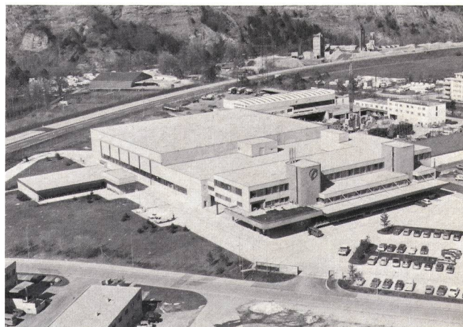
Fig. 1 Ansicht von Süden
