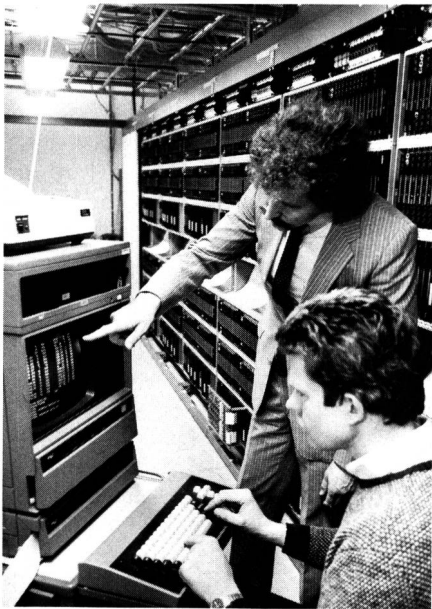
Fig. 4 Testarbeiten in einer digitalen Zentrale
