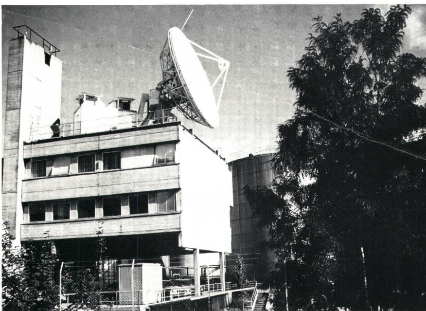
Fig. 1 Die IBS-Satelliten-Bodenstation der PTT für besondere Geschäftsverbindungen über Intelsat mit den USA. Benützt wird ein Satellit im Westen des Atlantiks (deshalb die geringe Neigung der Antenne), damit Verbindungen mit den USA bis an deren Westküste möglich sind
