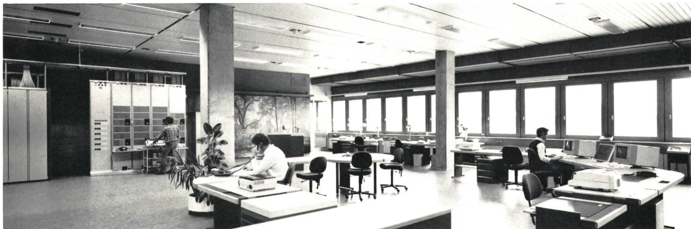
Fig. 11 Centro di gestione locale della centrale di transito Berna-Ittigen
