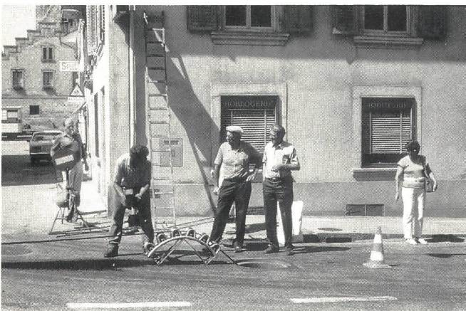
Fig. 8 Direkter Auszug des Kupferbündels auf die Fahrbahn. Das Aufwickeln in Containern geschieht in einer zweiten Phase
