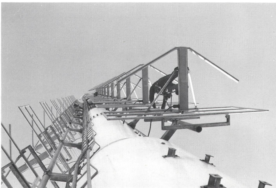
Fig. 10 Arbeit an Antennenträger
