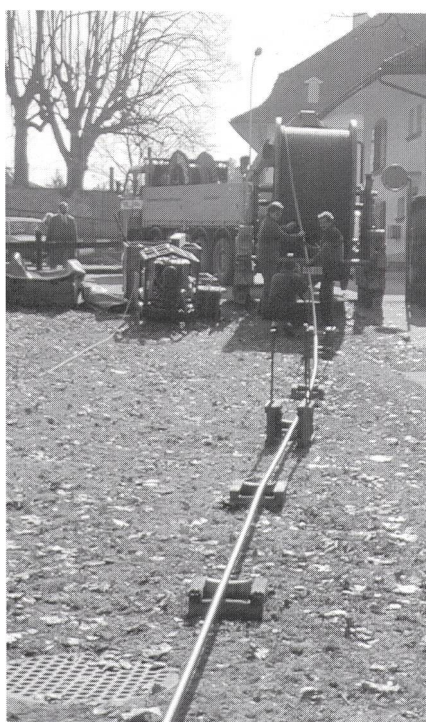
Fig. 3 Abrollen des Kabels
