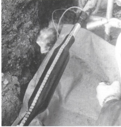
Installationen einer XAGA-500-Verbindungs- muffe
