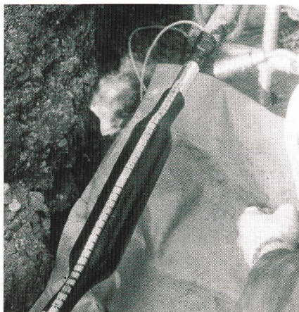
Installation einer XAGA-500-Verbindungs-muffe mit integrierter Feuchtigkeitssperre
