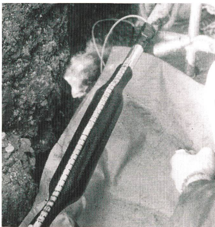
Installation einer XAGA-500-Verbindungs-muffe mit integrierter Feuchtigkeitssperre
