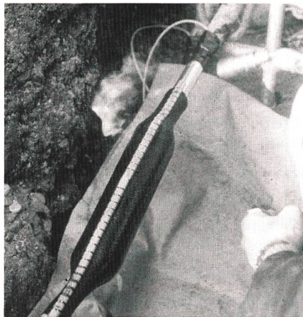
Installation einer XAGA-500-Verbindungs-muffe mit integrierter Feuchtigkeitssperre
