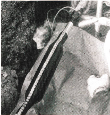
Installation einer XAGA-500-Verbindungs-muffe mit integrierter Feuchtigkeitssperre
