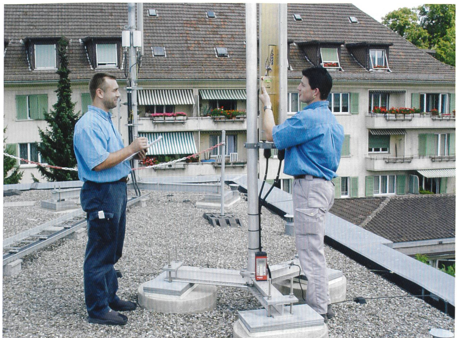
Bild 2. Distanzen und Antennenwinkel werden exakt ausgemessen, Gebäudematerialien ermittelt und Dachfenster, Oberlichter sowie zugängliche Orte, OMEN und OKA fotografiert. Es entsteht ein umfassendes NIS-Aufnahmedossier, das für die anschließende NIS-Berechnung unverzichtbar ist.
