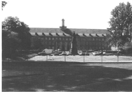
Verwaltungsgebäude der Wojewodschaft Koszalin. Foto: Benno Jurt
