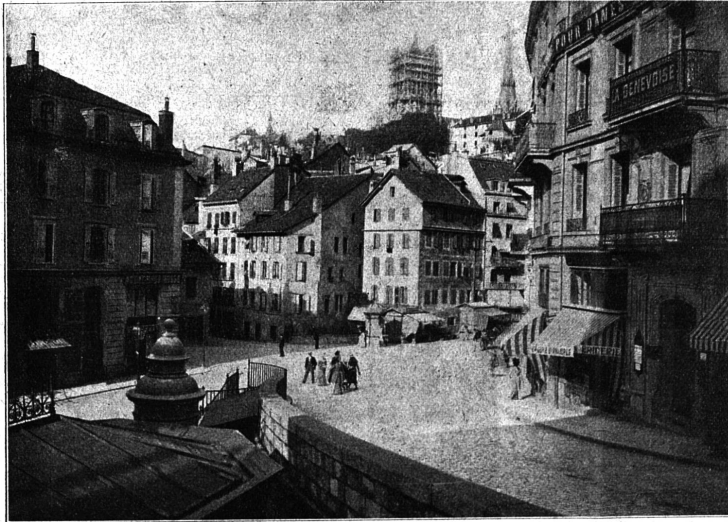
Carrefour, place et rue Pepinet et rue Centrale vers 1900. La grande fontaine de la rue Centrale, enlevée en 1888, n'existe plus, ni le bassin plus petit qui lui avait succédé pendant quelques années. Le beffroi de la cathédrale est entouré de ses échafaudages, et la maison Odot n'a pas encore subi l'incendie de 1901 ni l'exhaussement qui en a été la suite. Au centre, on remarque les anciens locaux de l'imprimerie Allenspach, et, plus à droite la maison Brunner. A gauche, on aperçoit un fragment de la façade de l'ancien « Café pointu » qui fut, de 1887 à 1904, le modeste berceau du Dispensaire central.
