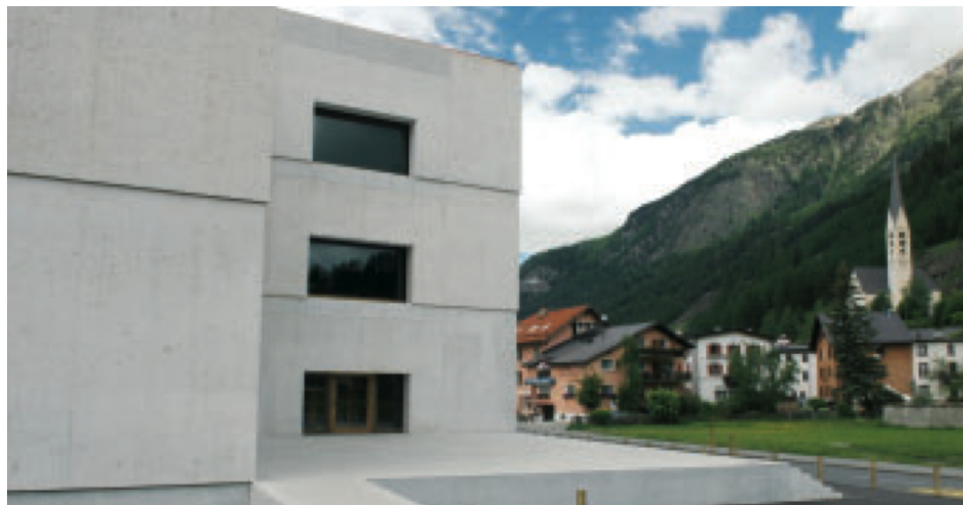
Das neue Nationalparkzentrum
