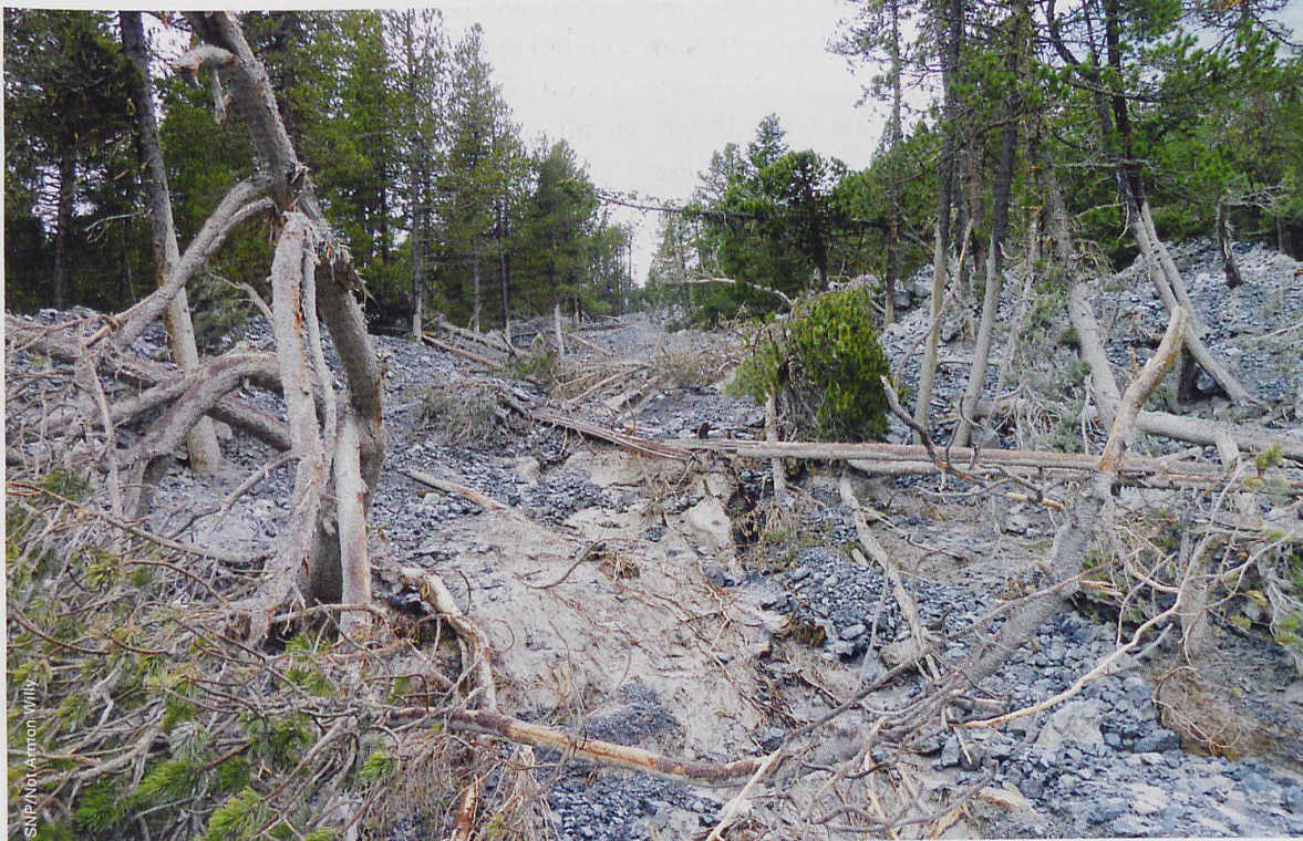
Abb. 7 Der Murgang aus dem Laviner Grond bahnte sich eine Schneise durch den Bergföhrenwald und riss den Wanderweg mit.
