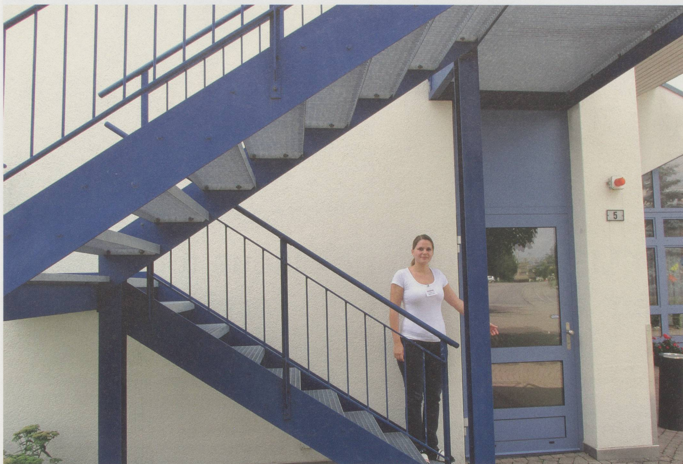
L'escalier de secours est conforme aux normes de sécurité, indique Cornelia Ure. Mais elle doit sans cesse veiller à ce qu'il n'y ait pas de déambulateur parké devant la porte de sortie.
