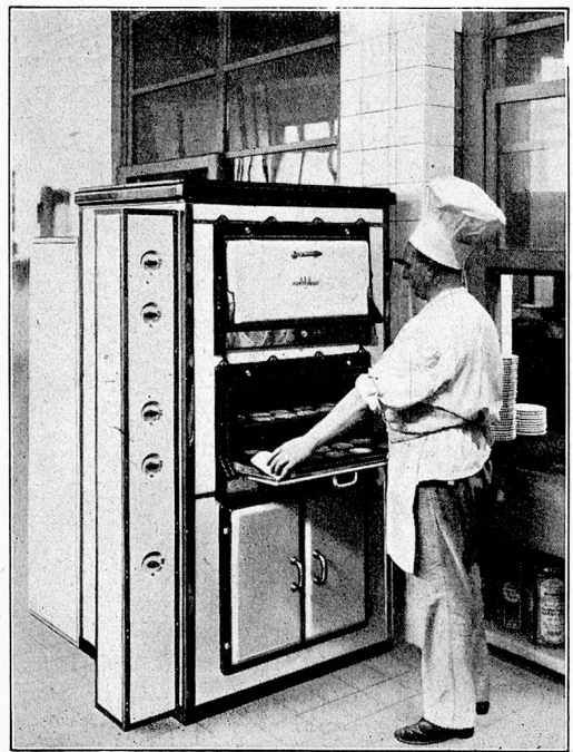
Elektrokonditorei - Backofen mit 2 Backröhren und einem Gärschrank
