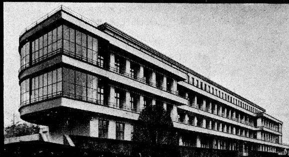
Inselspital Bern Selbsttätige Heizregelanlage System Landis & Gyr
