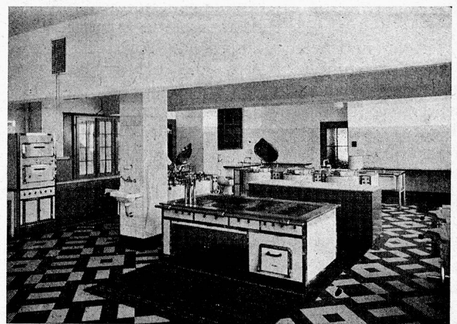
Teilansicht der elektrischen Küchenanlage des Niederländischen Sanatoriums, Davos.
