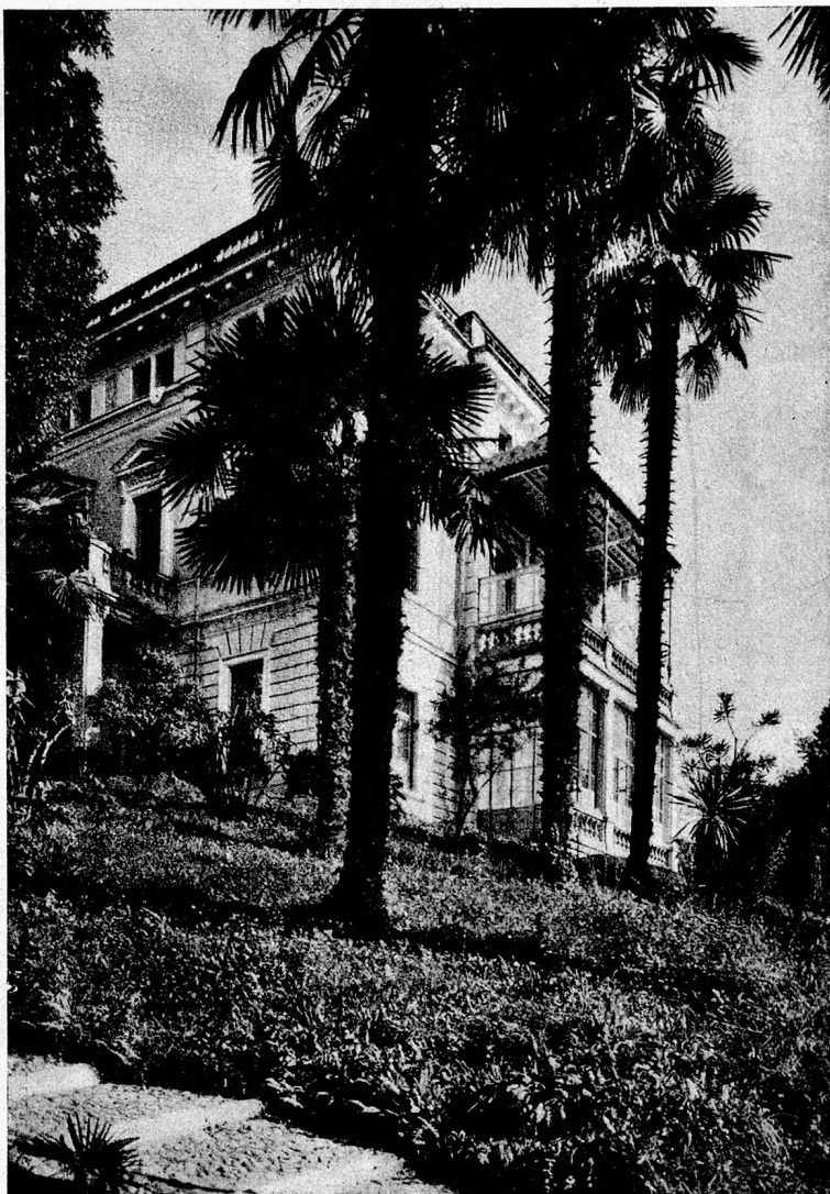
Casa di cura Villa Montana, Locarno-Muralto
