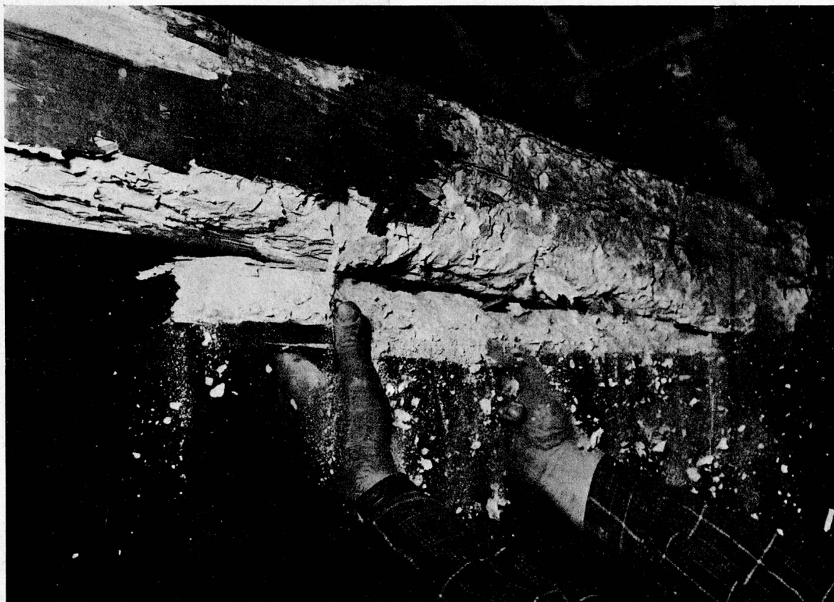
Schaden des Hausbocks in einem Dachstock
