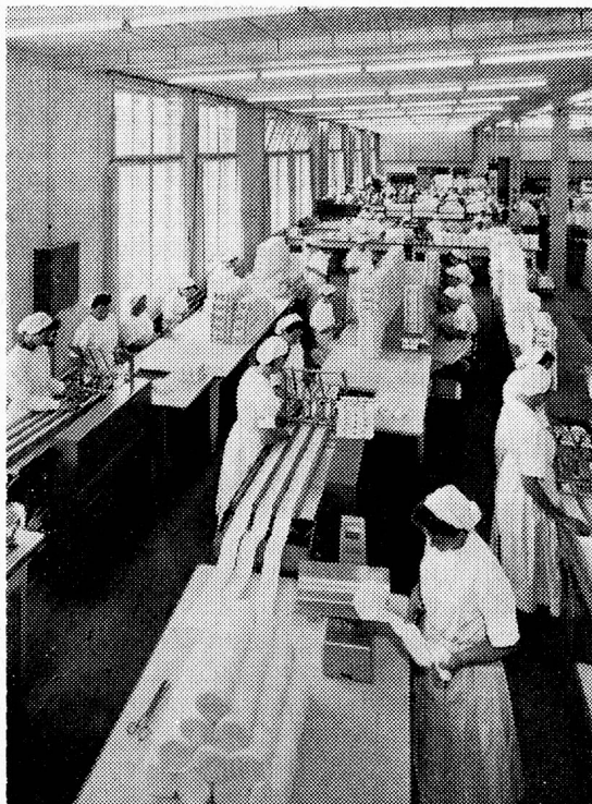
Blick in einen Verpackungssaal der Internationalen Verbandstofffabrik Schaffhausen
