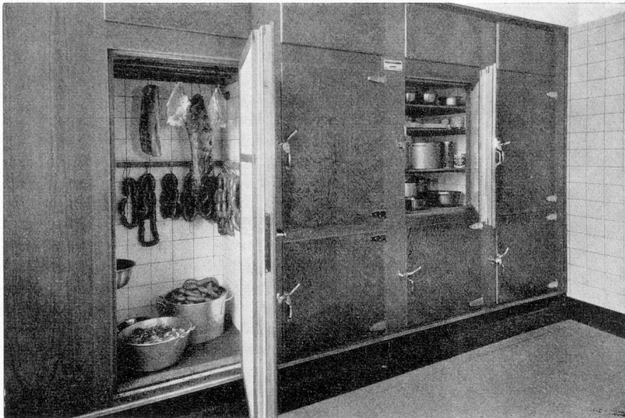
FRIGOREX-Küchenkühlschrank Beispiel eines in einer geräumigen Küche eingebauten Kühlschranks. Die Möglichkeit des Einbaues in der Küche erspart den Weg in den separaten Kühlraum. Temperatur zirka +3° C, also nicht für Tiefkühlung bestimmt.
