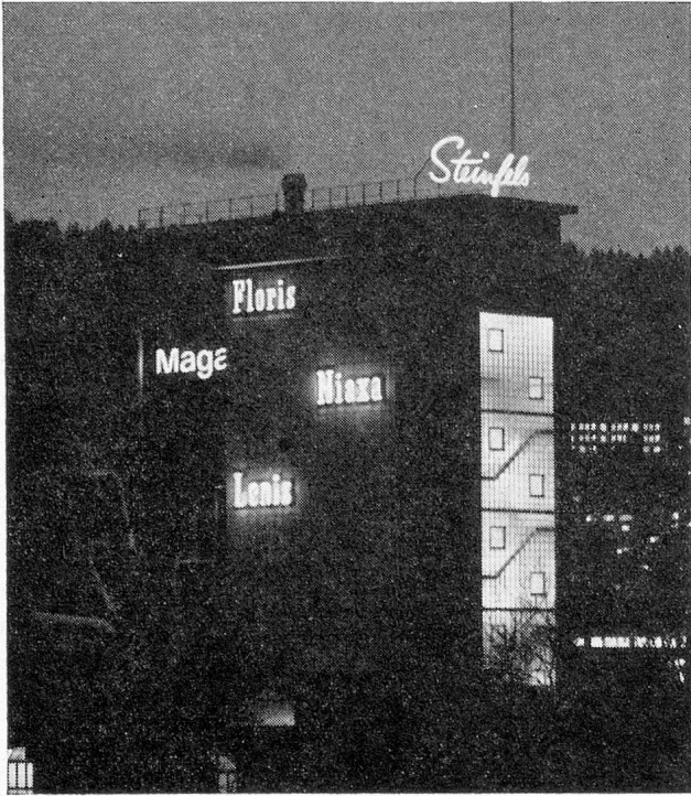
Der imposante Turm mit der Zerstäuberanlage (Nacht-aufnahme)
