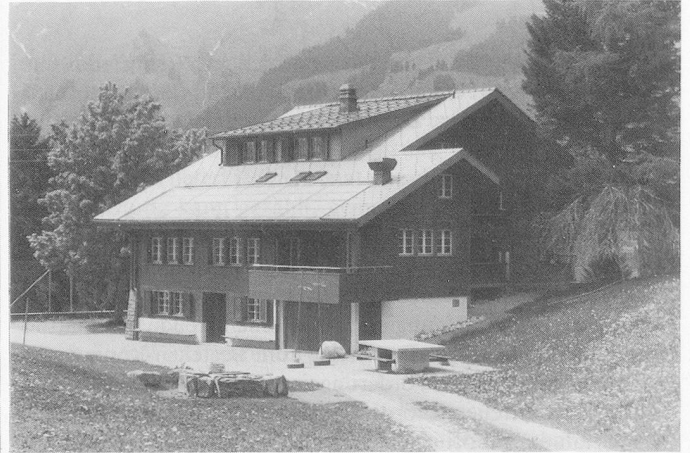
Sonnenenergie für das Ferienhaus «Marchgraben»: Energiespeicher im Haus; 38 Quadratmeter Solarzellen.
