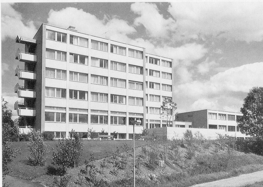
Alters- und Pflegeheim Falkenhof, Aarburg, vor zwanzig Jahren. Westfassade – heute um 2,50 Meter vorversetzt und saniert.
