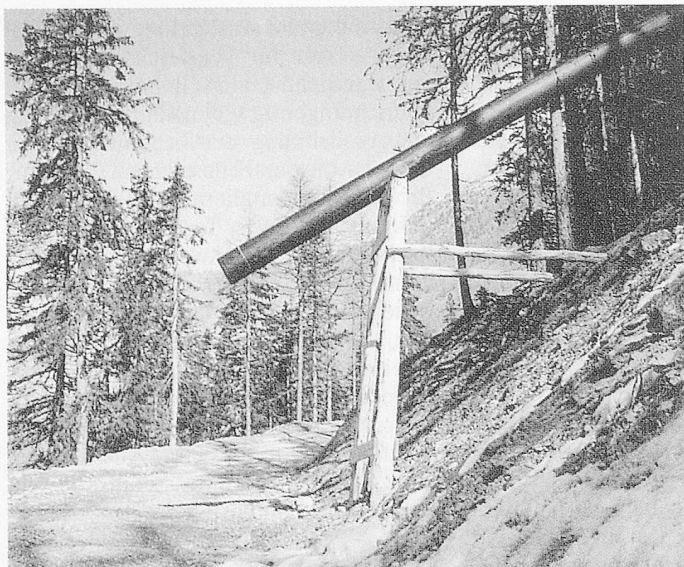
Kein neues Wasserkraftwerk! Die Holzschnittelleitung zum Laden des Container-Lastwagens führt im freien Fall vom Hackerplatz mit Vorrats-Container zum abgebildeten Ladeplatz. Der Vorrats-Container dient als Zwischenlager zur Verkürzung der Lastwagen-Wartezeiten.
