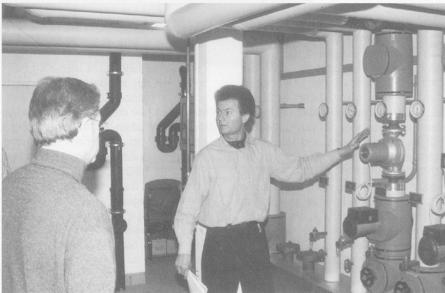
Urs Renggli (rechts) erklärt die Einrichtungen des Heizkreislaufes des Alters- und Pflegeheims Biberzellen in Lachen.
