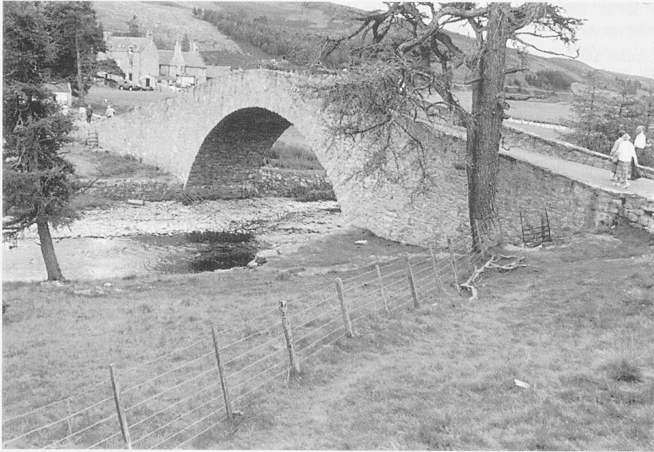
Brücke in den schottischen Highlands; Foto Erika Ritter
