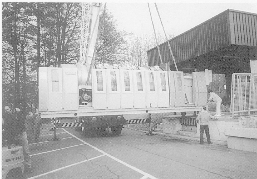
Mit Hilfe eines Spezialkrans wurde der Schulthess TWE 450 in die Regionalwäscherei Baden eingebracht.
