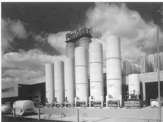
Das Umfüllwerk Dagmersellen stellt die Versorgung der Zentral-, Nord- und Südschweiz mit technischen und medizinischen Gasen und Gasgemischen sicher.
