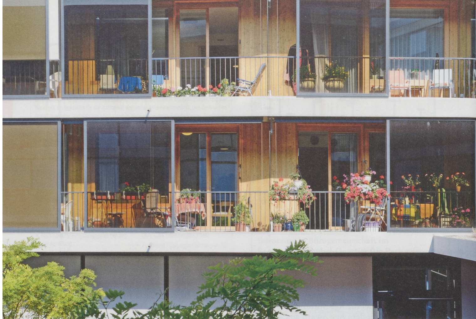
Balkonfront des Neubaus Alterszentrum Lanzeln Stäfa: Das Haus erinnert eher an ein modernes Hotel als an ein Alterszentrum.
