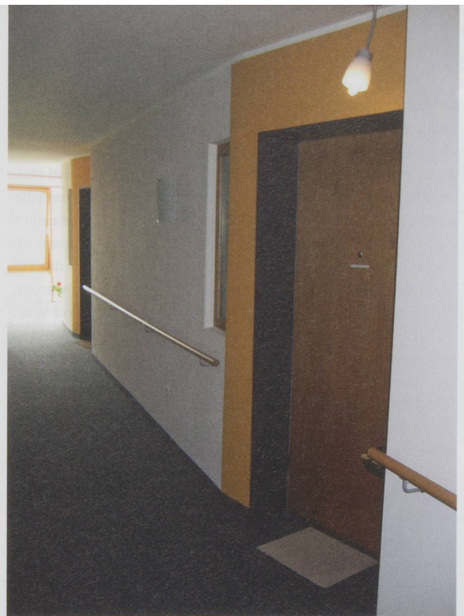
Türen bündig mit den Wänden und aus dem gleichen Material: Menschen mit einer Sehbehinderung haben keine Chance, ihr Zimmer zu finden (l.). Farbliche Kontraste, Türen innen angeschlagen und als Eingang «zelebriert»: vorbildlich (r.). Fotos: F. Bohn
