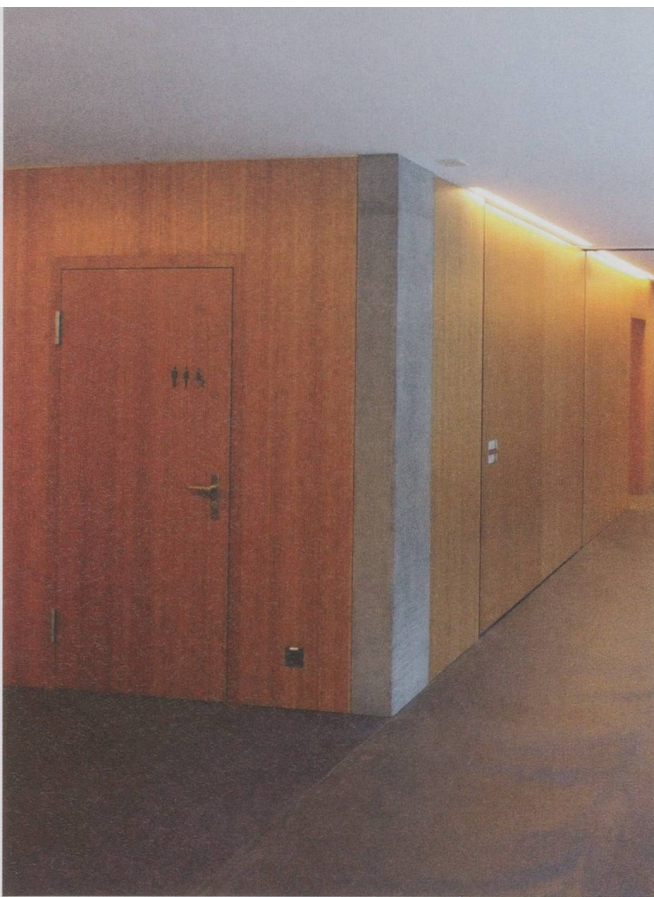
Türen bündig mit den Wänden und aus dem gleichen Material: Menschen mit einer Sehbehinderung haben keine Chance, ihr Zimmer zu finden (l.). Farbliche Kontraste, Türen innen angeschlagen und als Eingang «zelebriert»: vorbildlich (r.). Fotos: F. Bohn
