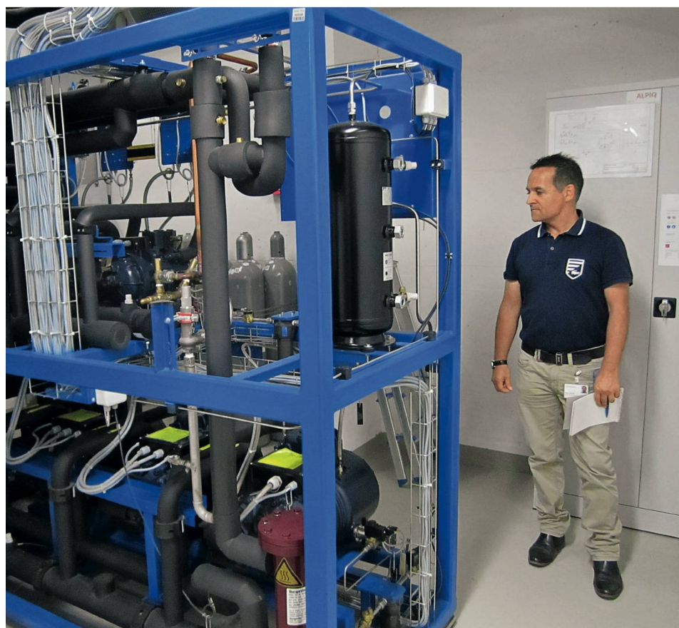
«Die Art der Kühlung gilt heute als die umweltfreundlichste»: Andreas Meyer, Leiter Facility Management bei der Spital STS AG Thun, im Kompressorenraum, von wo die Kühlzellen (rechtes Bild) mit Kühlmittel versorgt werden.
