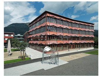
Der rote Neubau der Tagesstätte Weidli in Stans NW.
