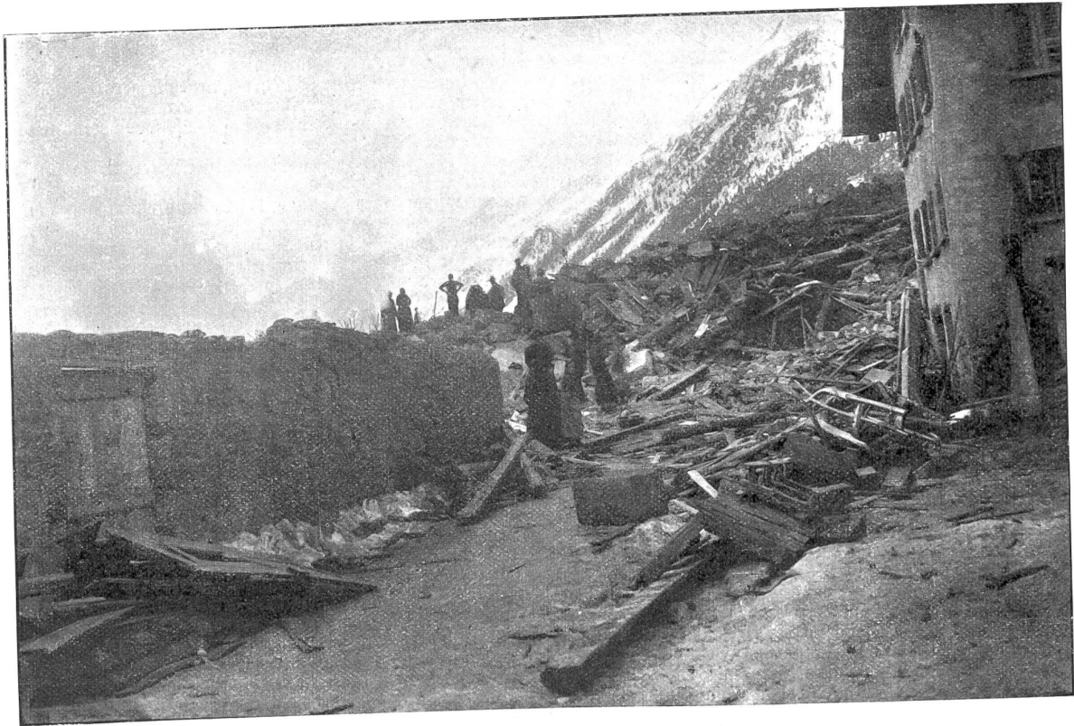
Die verschüttete Gotthardstraße. Phot. J. Gafler, Andermatt.
