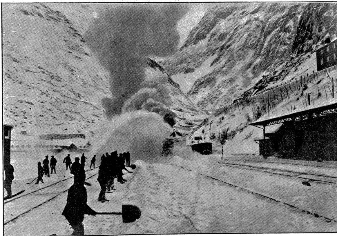
Die Schneeschleudermaschine der Gotthardbahn. Vergl. Text S. 161.
