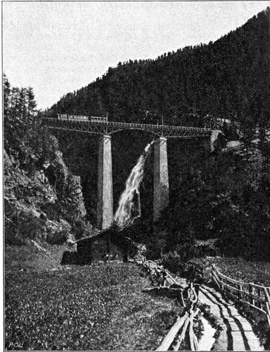
Gornergrat-Bahn. — Findelbachbrücke. Phot. Gebr. Wehrli, Kilchberg bei Zürich.
