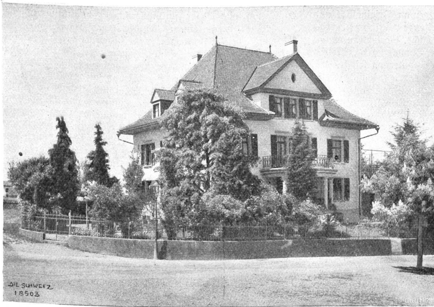
H. Brenner & W. Stutz, Frauenfeld. Wohnhaus von Regierungsrat Kreis in Frauenfeld (nach dem Umbau). Phot. B. u. C. Lutz, Zürich.
