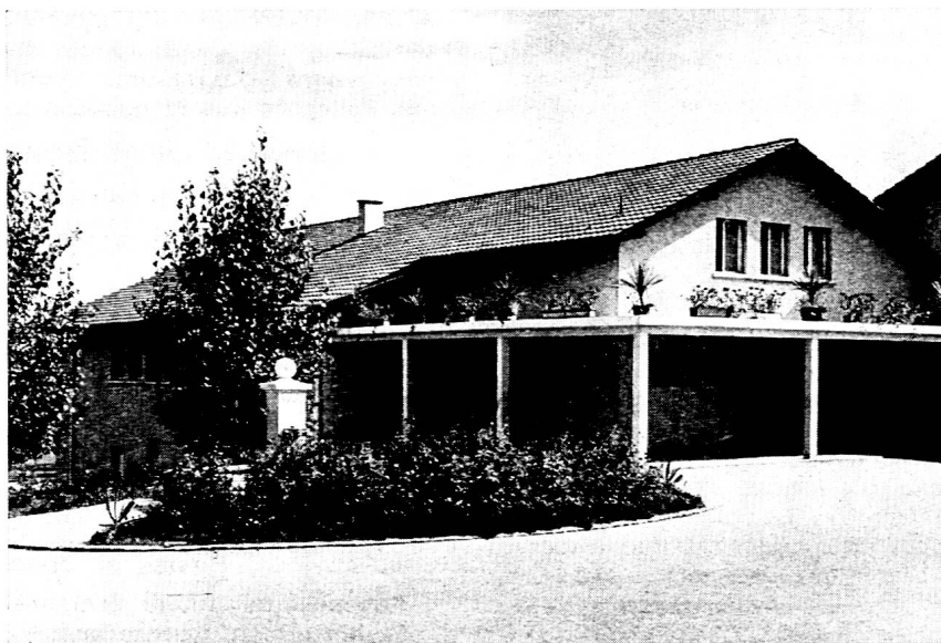
A l'école Pestalozzi, des bâtiments neufs et accueillants ont pu être construits. Ici : le bâtiment central comprenant cuisines, réfectoires, lingerie et buanderie.
