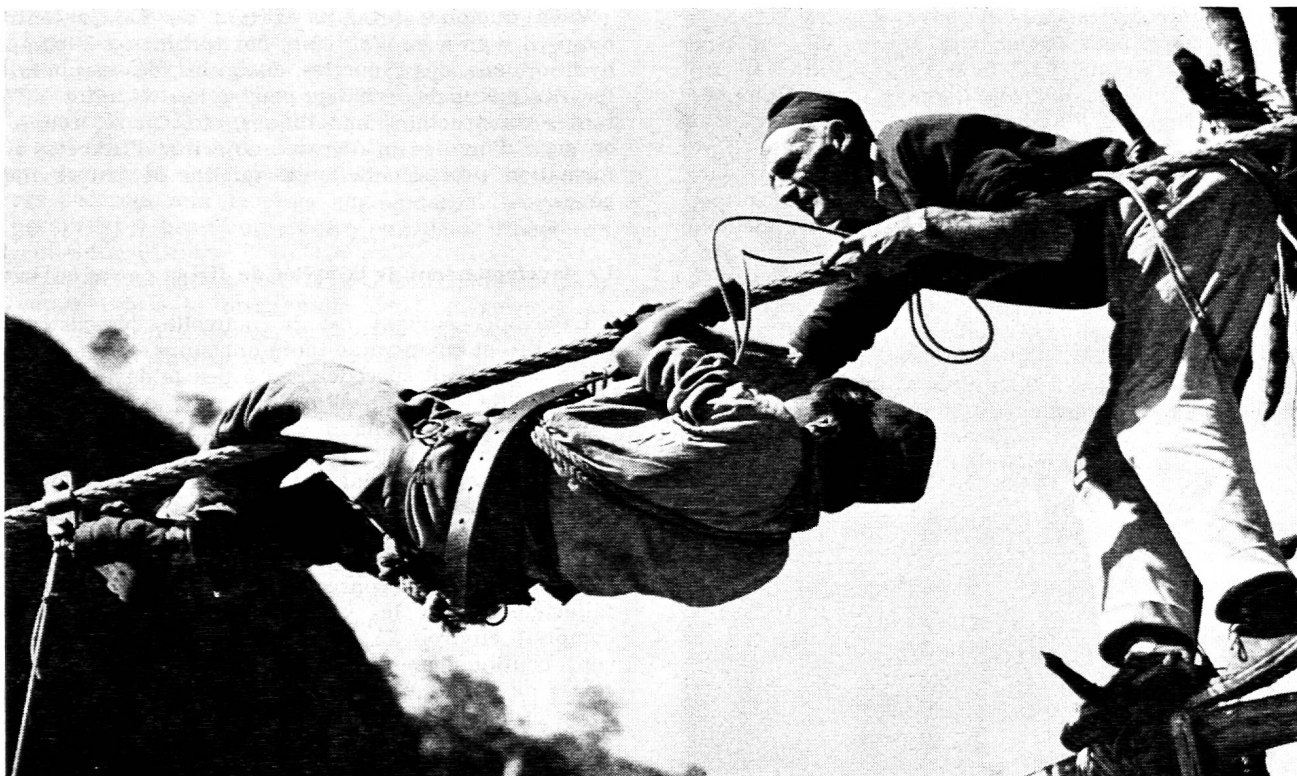
Le chef monteur Alois Lütolf, de Lucerne, et un contremaître népalais, montant un pont suspendu au-dessus du Marsyandi près de Sattale.
