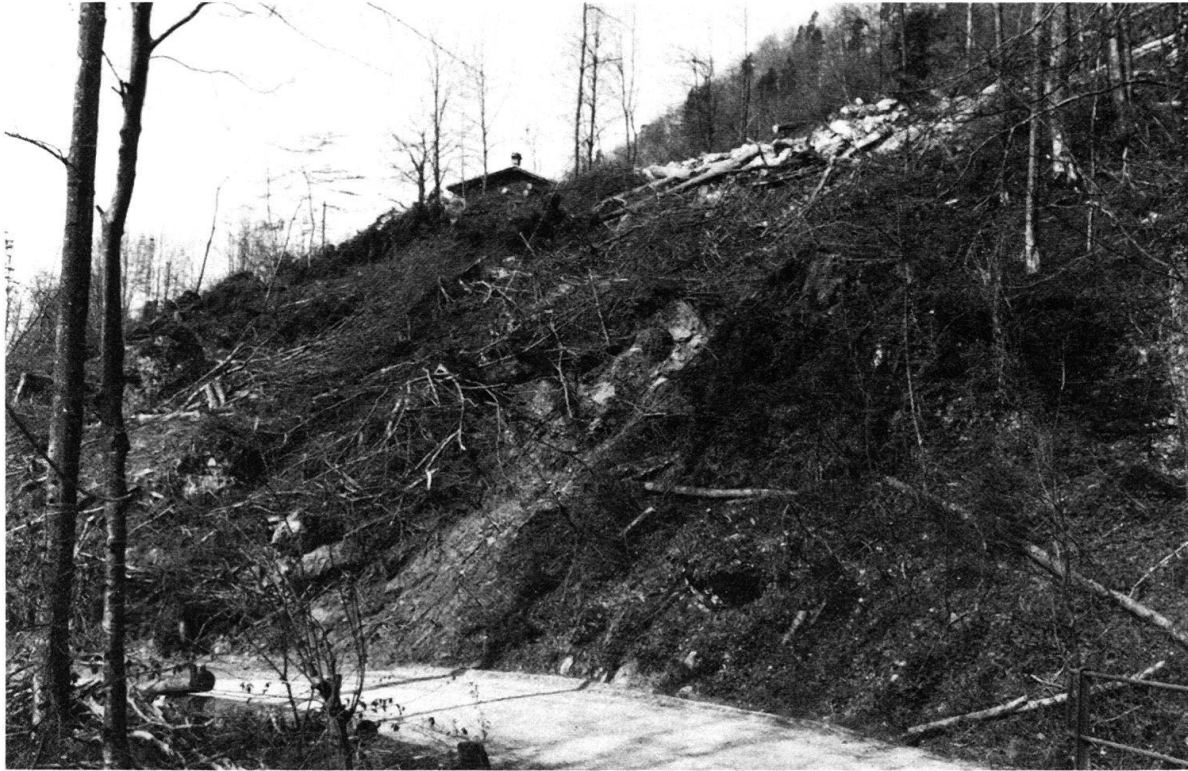
Fig. 3. Wegen lokaler Instabilitäten in den Böschungen mussten Bäume gefällt und schwach eingebundene Blöcke gesprengt werden. Am oberen Bildrand Dach des Hauses 1 (Aufnahme: 7. Mai 1979). (Bild: Neg. Nr. 9/50/15A; 7. Mai 1979.)
