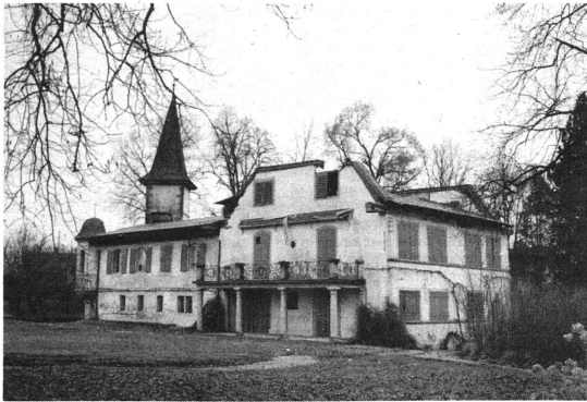
La nuit du 3 au 4 novembre 1974, la maison de Gonzague de Reynold, à Cressier/Morat, était la proie des flammes. Les combles furent entièrement détruits, ainsi que le second étage. Planchers, boiseries, plafonds, furent gravement endommagés par l'eau, ainsi que les peintures murales qui ornaient les pièces de réception.
