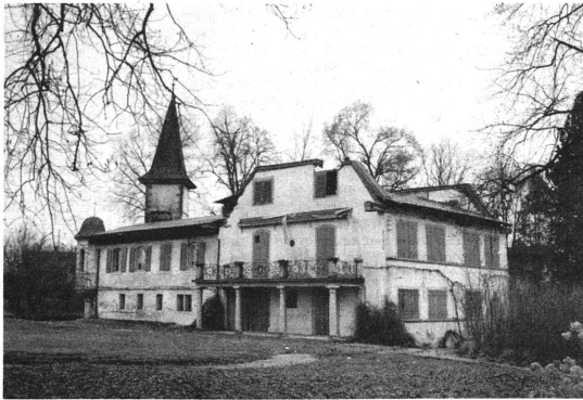
La nuit du 3 au 4 novembre 1974, la maison de Gonzague de Reynold, à Cressier/Morat, était la proie des flammes. Les combles furent entièrement détruits, ainsi que le second étage. Planchers, boiseries, plafonds, furent gravement endommagés par l'eau, ainsi que les peintures murales qui ornaient les pièces de réception.
