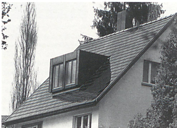
Dacherneuerung mit integrierten Sunslates (BS)
