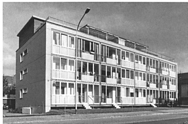
Haus Focus in Uster. 10 Familien bauten sich ein energieeffizientes, ökologisches und kostengünstiges Haus
