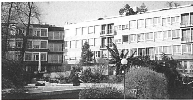
Bezirksspital Dielsdorf: Verschiedene Optimierungsmassnahmen sparen 20% des Gesamtenergieverbrauchs
