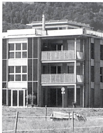
Synergiepark für erneuerbare Energie Eigentümer: Heidi und Peter Schibli, Gams
