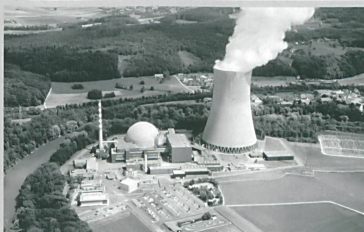
Kernkraftwerk Gösgen: Nach 30 Betriebsjahren ausschalten?
